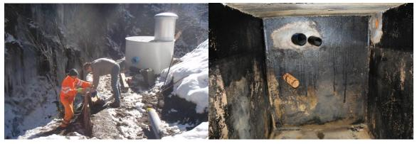
Setzen der neuen Druckkammer
