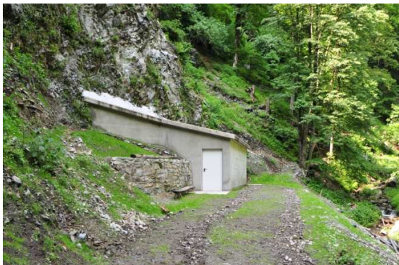
Nuova Camera di controllo e Sorgente 8
