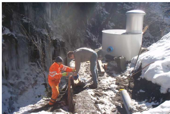
Posa nuova Camera di carico
